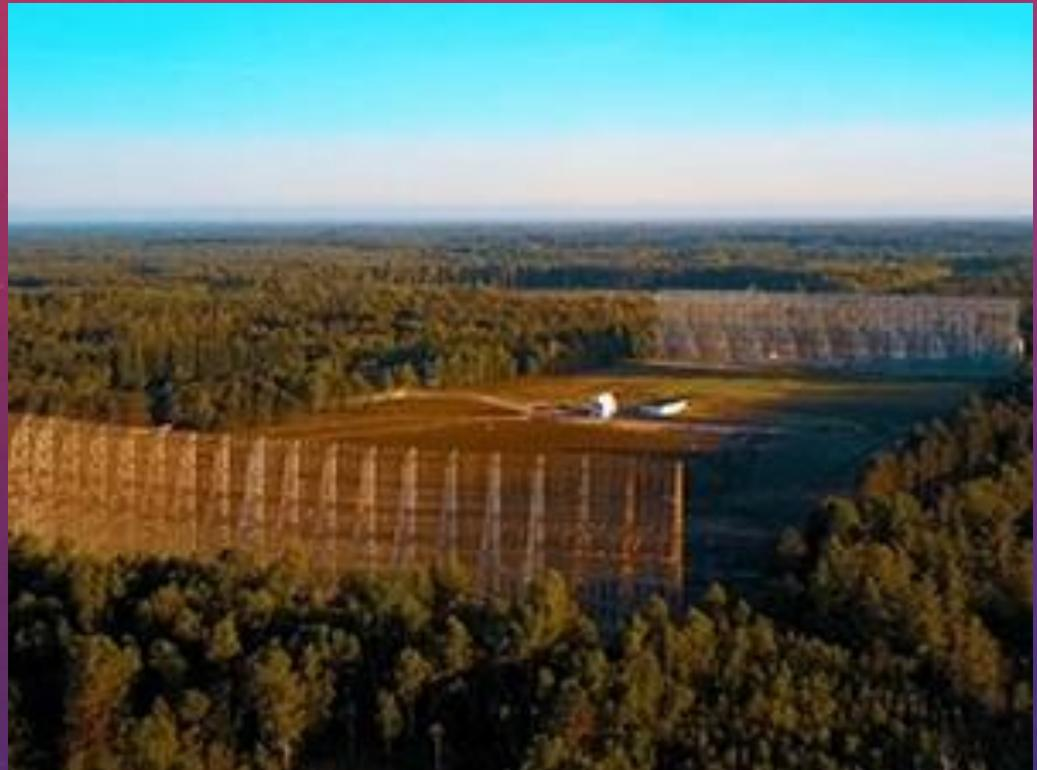
Radiotélescope composé d'un miroir plan orientable (200m x 40m). Son rôle : réfléchir les ondes vers le miroir sphérique (300m x 35m). Celui-ci les renvoie vers le chariot focal, au centre, où elles sont collectées.
